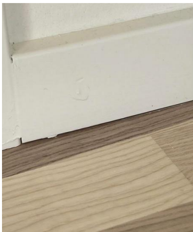
Minimal luft mellem gulvet og fodlisten
